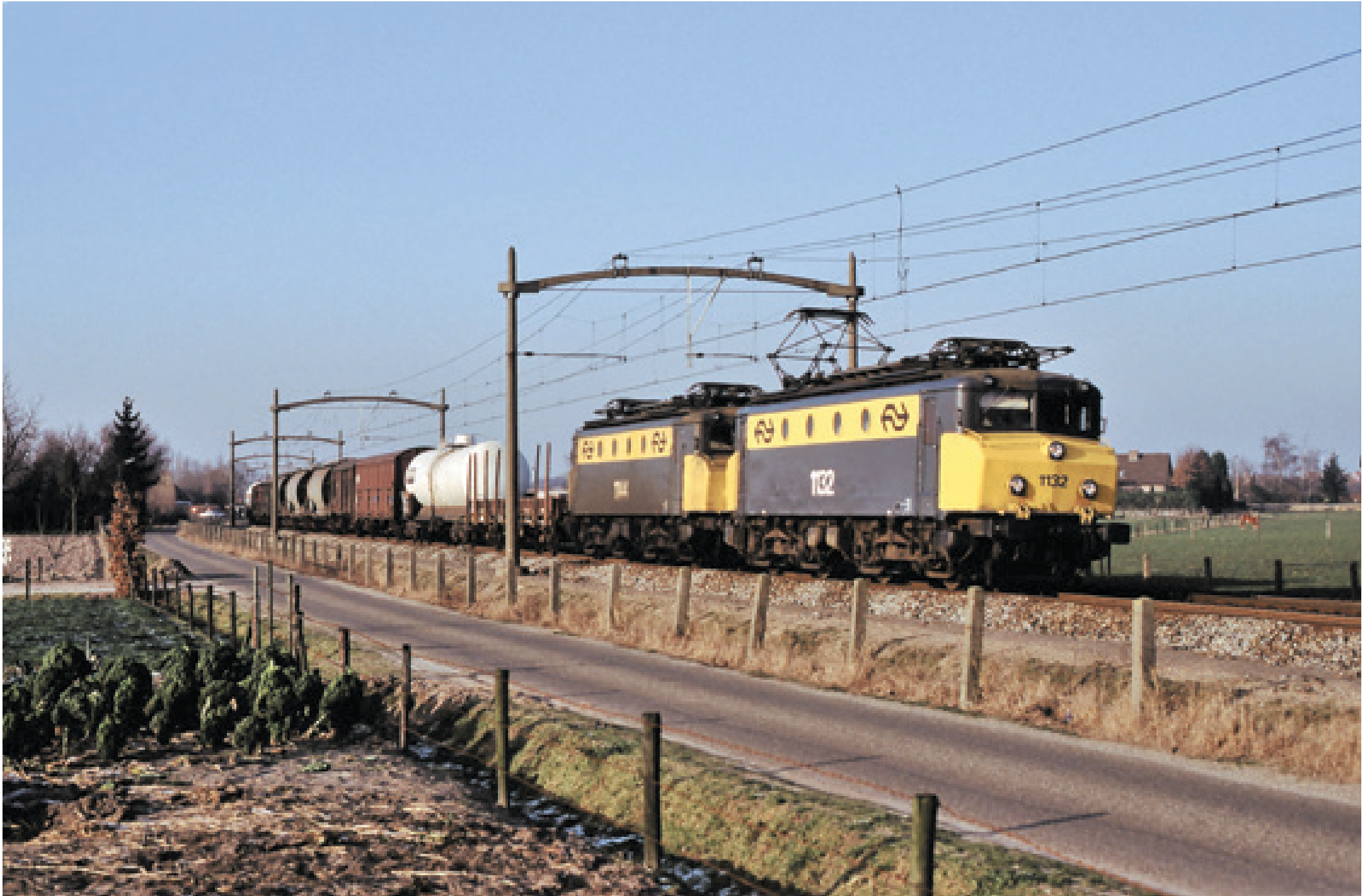
In januari 1950 kwam de lijn Dordrecht—Boxtel onder de draad. Hier werden zogenaamde Arkelportalen toegepast: ronde kolommen met lichtgebogen bovenbalken van beton. De 1132 en 1144 zijn op 3 januari 1993 met een gemengde goederentrein onderweg van de Kijthoek naar Venlo en passeren Prinsenbeek vlak voor Breda. Foto: John Krijgsman.
