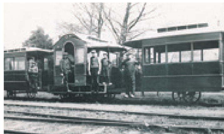
Boven: Trots staat de bestuurder van de Groenlosche Tram met de slinger in zijn hand waarmee hij de motor van 9PK kon aanzwengelen. Duidelijk zijn de beide éénassige rijtuigjes te zien op deze foto uit 1915. De tram had geen wagennummer.
