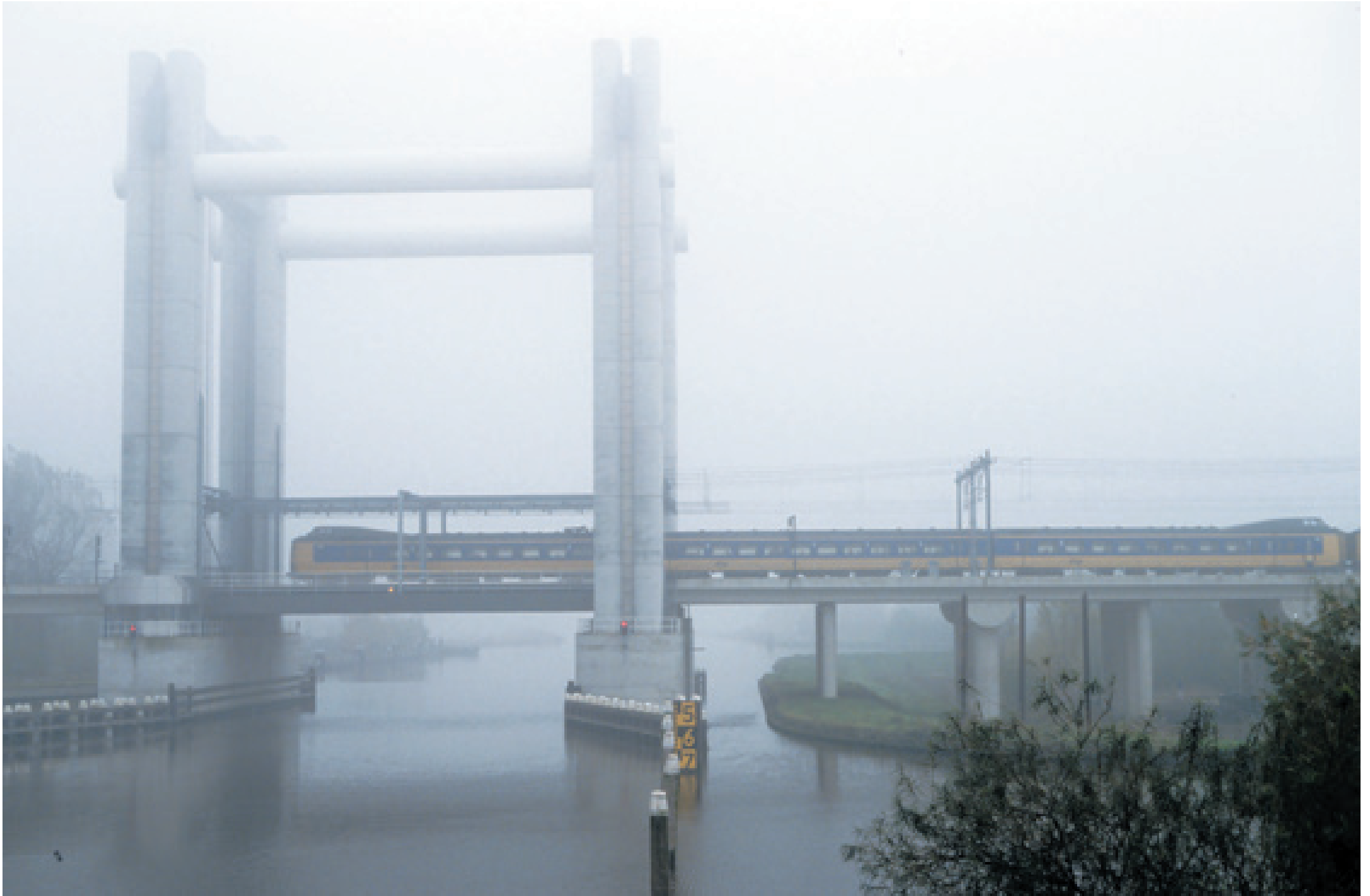
De Hoge Gouwespoorbrug bij Gouda werd in 1989 in gebruik genomen en is 41 meter hoog. De hefbrug heeft in de hoogste stand een doorvaarthoogte van 34 meter. De door architect R. Steenhuis ontworpen brug is door de heftorens in het landschap van verre herkenbaar, maar op een herfstdag in 1997 is de bovenkant nauwelijks zichtbaar in de mist. Tom Tand wist een Intercity richting Utrecht vast te leggen op deze sfeervolle foto.
