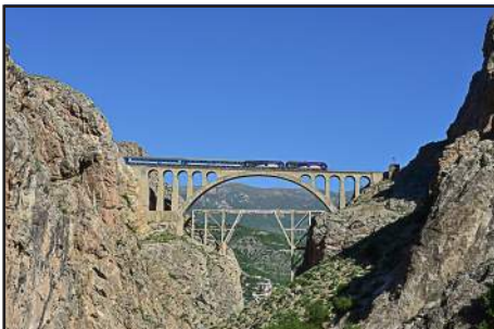
het viaduct van Veresk
